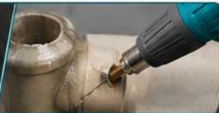
SOLDADURA DE PVC
